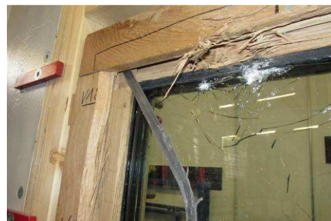
Bild 6 Schäden aus der manuellen Prüfung am Scherenlager
