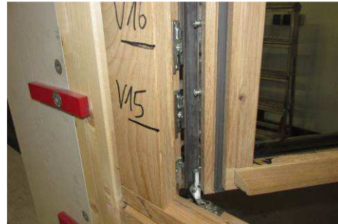
Bild 2 Ansicht des Ecklagerbereichs
