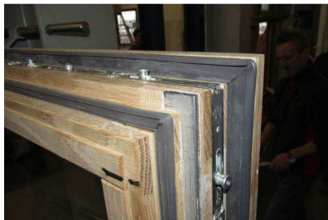
Bild 3 Ansicht des Gangflügels griffseitig mit Flachstahl
