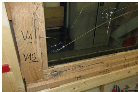
Bild 5 Schäden aus der manuellen Prüfung am Ecklager
